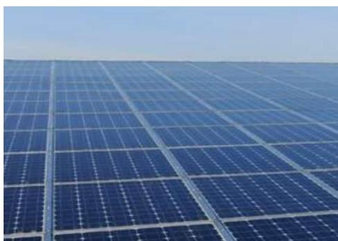
Figure 17 : Exemple de panneaux monocristallin
