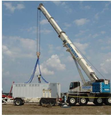
Figure 30 : Engin utilisé pour la pose des postes onduleurs
