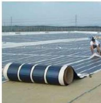
Figure 12 : Exemple de silicium amorphe (source Urbasolar)
