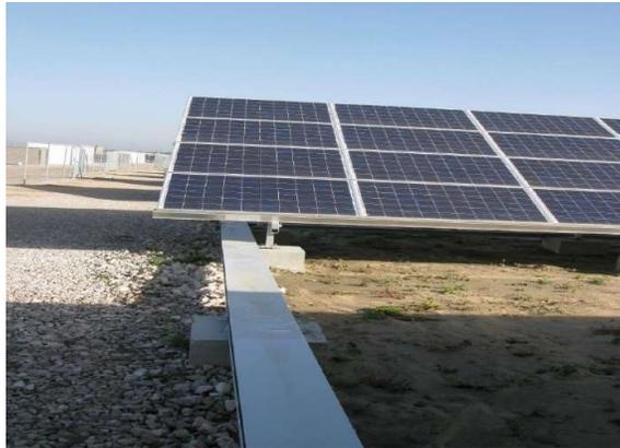
Figure 23 : Exemple d'un chemin de câbles
