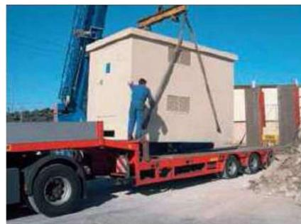
Figure 32 : Déchargement d'un poste électrique
